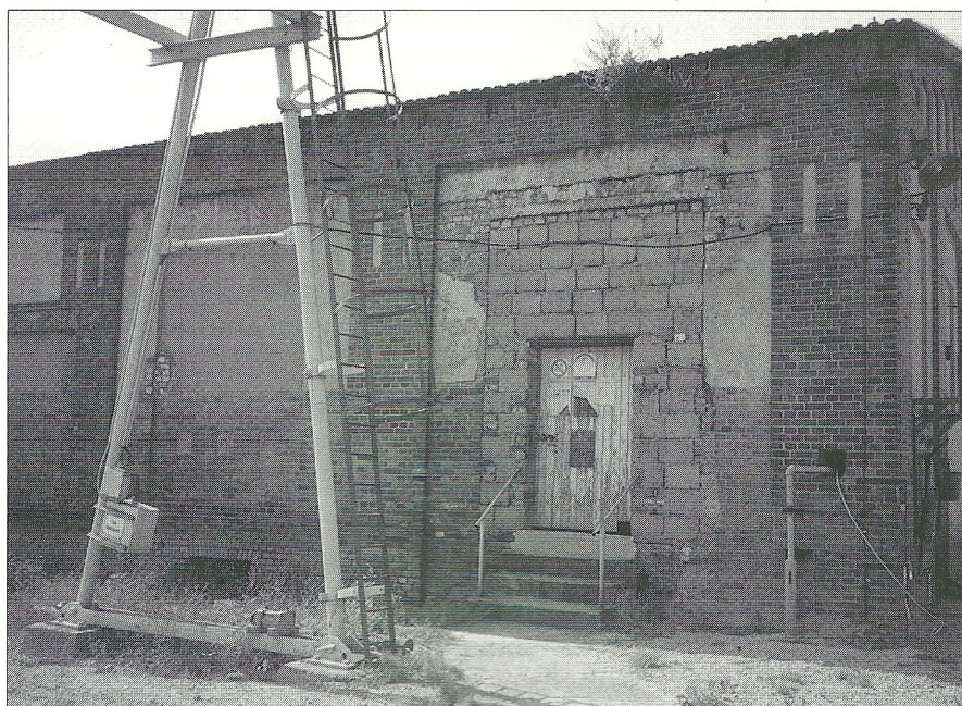
L'accès aux galeries de BILLRODA
