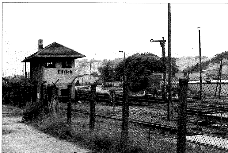
Poste d'aiguillage d'Ellrich. Le camp se trouvait de l'autre côté de la voie ferrée.
