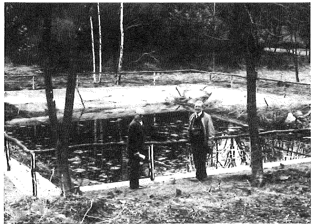
"La piscine" qui vient d'être dégagé.
