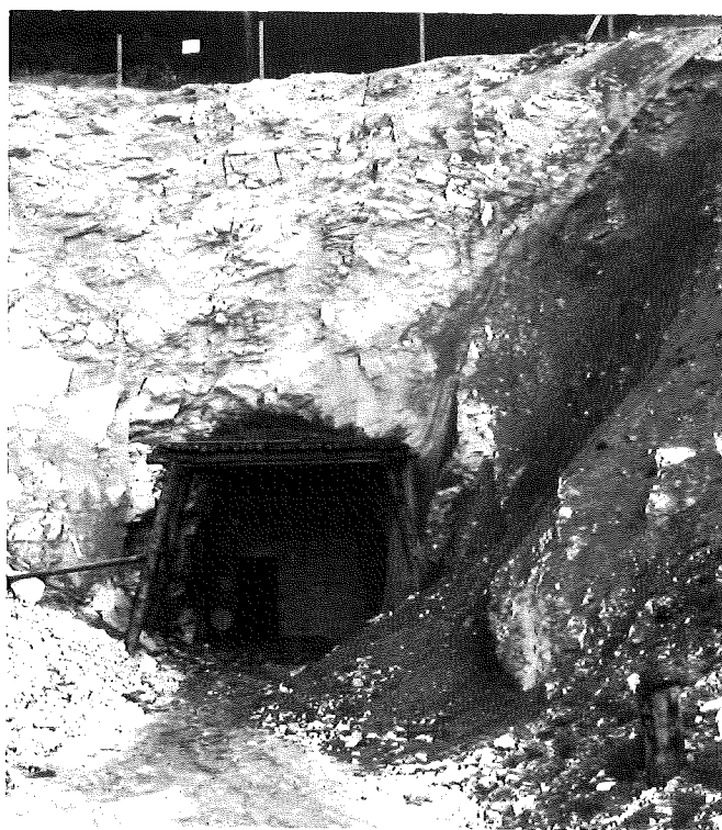
A droite l'entrée du Tunnel de Dora
