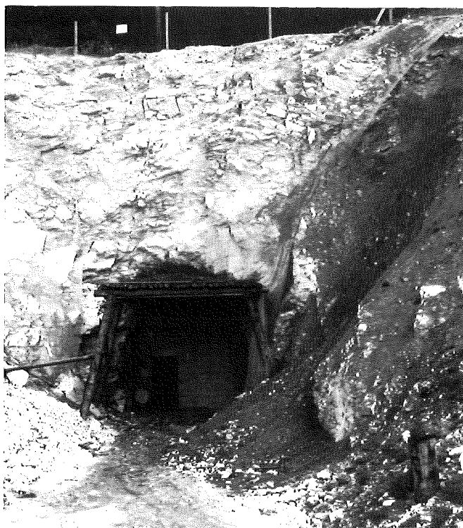
A droite l'entrée du Tunnel de Dora
