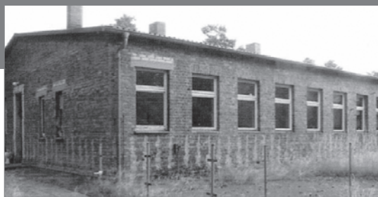
L'ancienne baraque de l'administration de l'usine – Le Mémorial aujourd'hui
